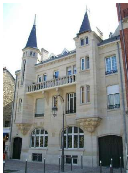
Immeuble réalisé par André Ragot, 3, place des Martyrs de la Résistance
