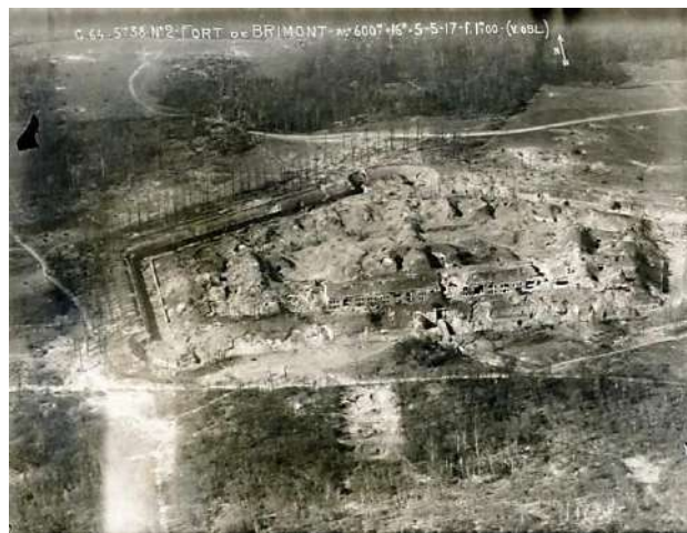
Fort de Brimont : on distingue plusieurs impacts de 400 Photo de l'escadrille C 64 - 5 mai 1917
