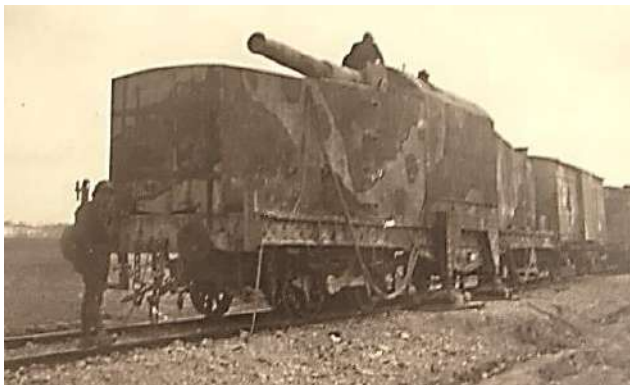
Près de Châlons-sur-Vesle, train blindé et pièce de 194 - mars 1917
