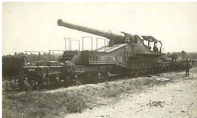
Cette pièce de 274 mm modèle 1893 avec affût à glissement de la 20 e Batterie du 77 e RALGP a été capturée par les Allemands le 27 mai 1918 après sabotage de la culasse démontée par les servants.
